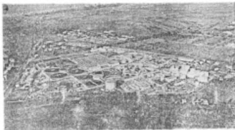
Il depuratore di Cuma visto dall'alto
