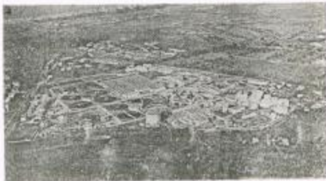
Il depuratore di Cuma visto dall'alto
